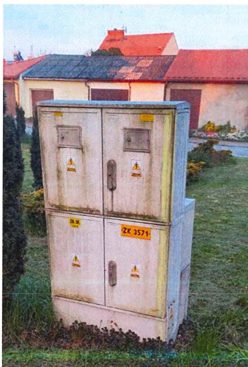
Rys. 4. Złącze kablowe ZK3571
