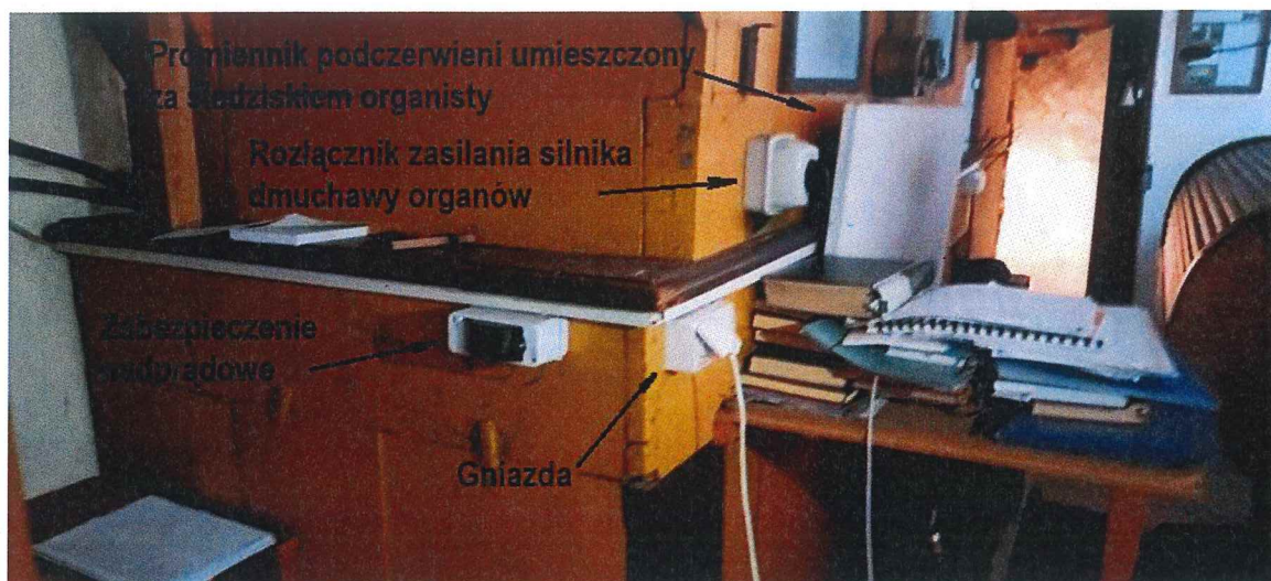
Rys. 11. Promiennik podczerwieni na chórze.
