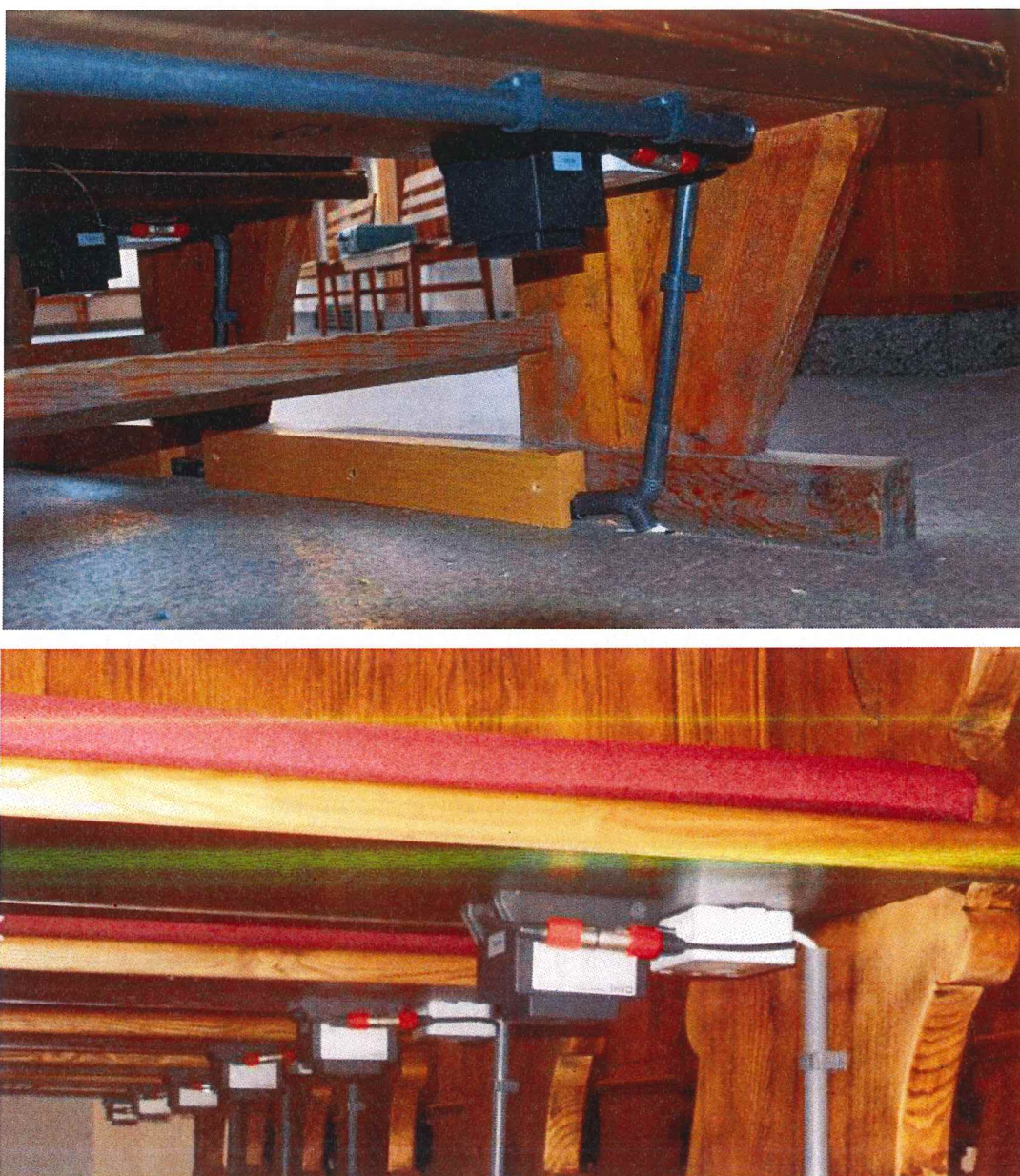
Rys. 36. Widok projektowanych instalacji ogrzewania ławek
