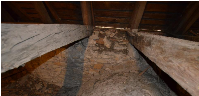
Fot.7. Stan zachowania korony murów; poniżej widoczne zwieńczenie lunety
