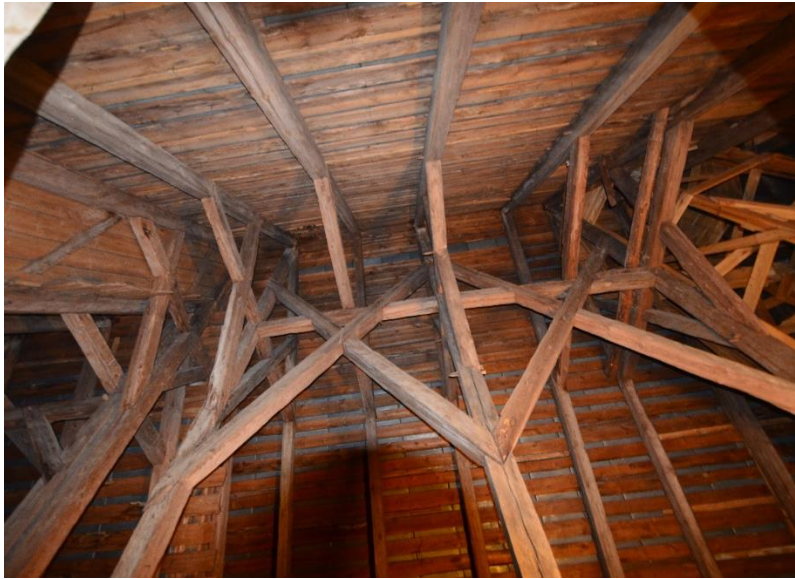
Fot.5. sposób połączenia konstrukcji dachu nad nawą główną oraz prezbiterium (po lewej stronie); Widoczna obróbka wewnętrzna ściany szczytowej
