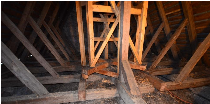
Fot.6. Konstrukcja sygnaturki
