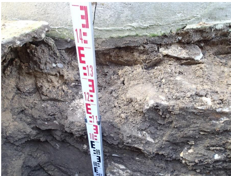
Fot.1. Odkrywka fundamentów przy ścianie absydy, w miejscu wystąpienia rysy widocznej na tynku – brak rysy na ścianie fundamentowej;
