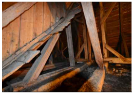
konstrukcja czoła ściany szczytowej dachu nad nawą główną
