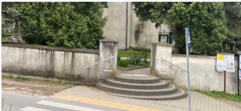
Fot 12. Schodki wejściowe na teren kościoła wykonane ze współczesnej kostki brukowej
