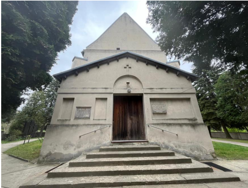
Fot. 13. Elewacja wejściowa, południowo-zachodnia ze schodami betonowymi
