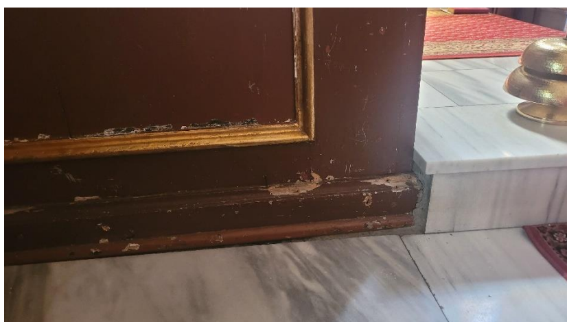
Fot.32. Sposób osadzenia ołtarza głównego
