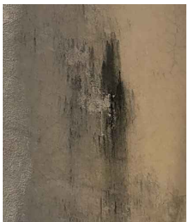
tynk na absydzie z licznymi zabrudzeniami i pęknięciami włosowatymi praktycznie na całej powierzchni; miejscami złuszczenia warstw malarskich;
