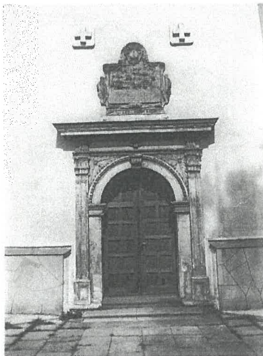
Fot. 6 Portal w fasadzie.
