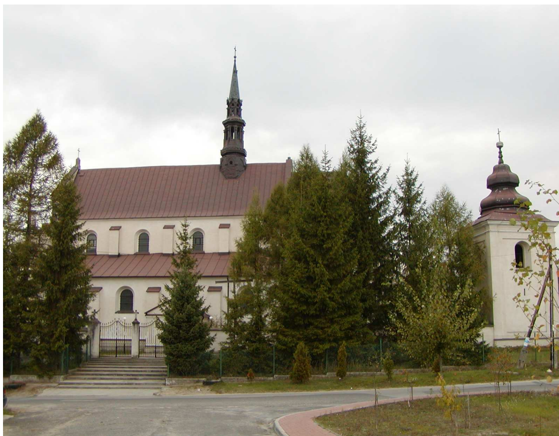
Fot. 5. Kościół Świętej Trójcy w Rakowie fot. Urząd Gminy Raków
