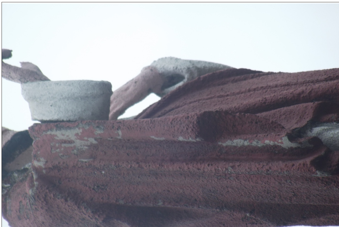
18. Figura Chrystusa pokryta wtórną warstwą farby. Widoczne liczne odspojenia i złuszczenia. Brak oryginalnej polichromii.
