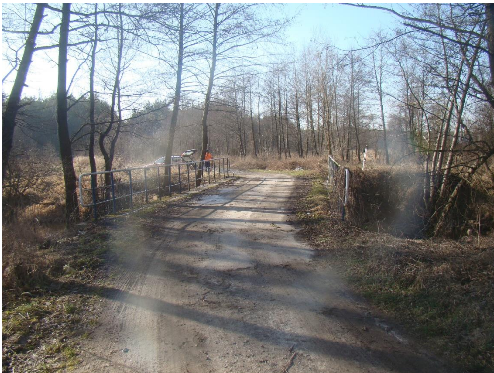
Rys. 2.2. Widok od strony podpory lewobrzeżnej.
