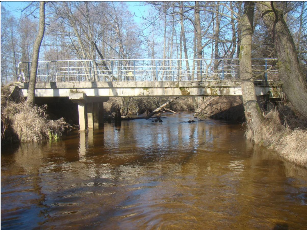
Fot. 2. Most drogowy przez rzekę Czarna w miejscowości Dębno - widok od strony wody dolnej.
