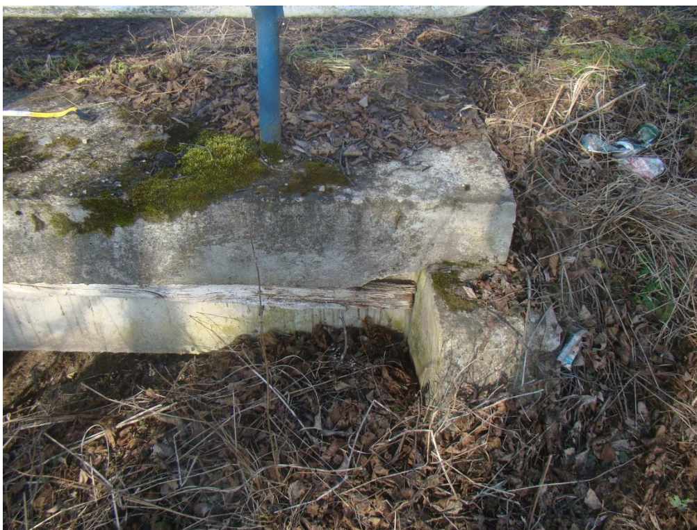
Rys. 2.3. Widok na podporę.
