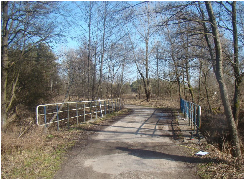
Rys. 2.1. Widok od strony podpory prawobrzeżnej.
