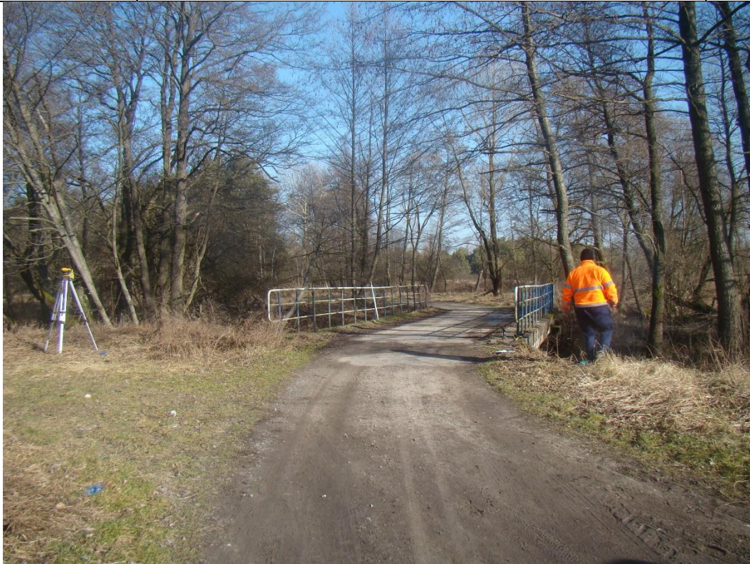
Fot. 1. Most drogowy przez rzekę Czarna w miejscowości Dębno - widok w kierunku m. Dębno.
