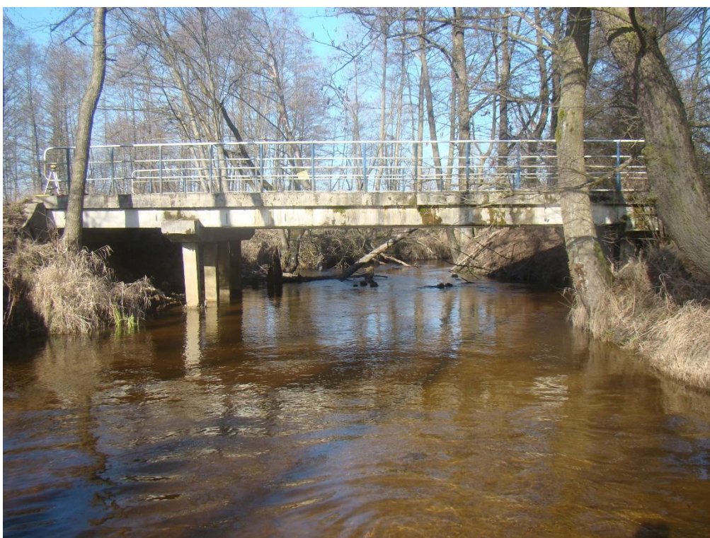
Rys. 2.5. Widok od strony wody dolnej.
